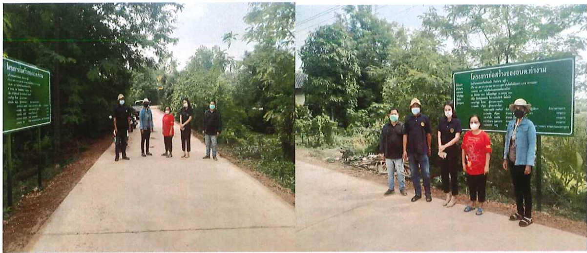
ปรับปรุงผิวถนนคอนกรีตเสริมเหล็กโดยใช้แอสฟัลติก หมู่ที่ 6
